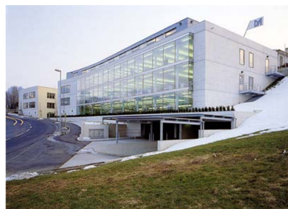
Entreprise industrielle à Wollerau (Schwyz) chauffée et rafraîchie depuis 1995 par un champ de sondes:
