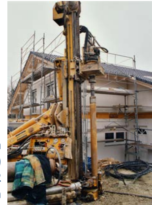
Sonde géothermique verticale (SGV) pour une villa familiale
