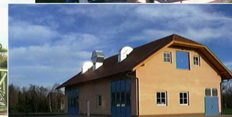
Krafthaus geothermische Stromerzeugung ↑ Centrale ORC d'Altheim ↓
